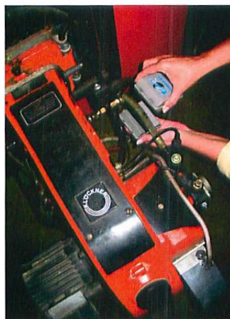
Der Ecojet wird an die bestehende Anlage montiert und optimiert die Verbrennung.
