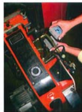
Der Ecojet wird an die bestehenden Anlage montiert und optimiert die Verbrennung.
